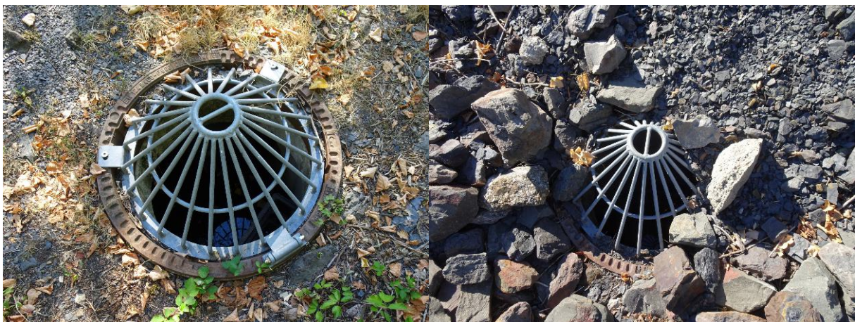
Abb. 1: Die mit der Geländeoberkante abschließenden Entwässerungsschächte auf der Halde müssen zur Einhaltung des Tötungsverbots gemäß § 44 Abs. 1 BNatSchG zeitnah identifiziert und entschärft werden (Fotos: Wendelin Schmitt, 07.08.2022).
